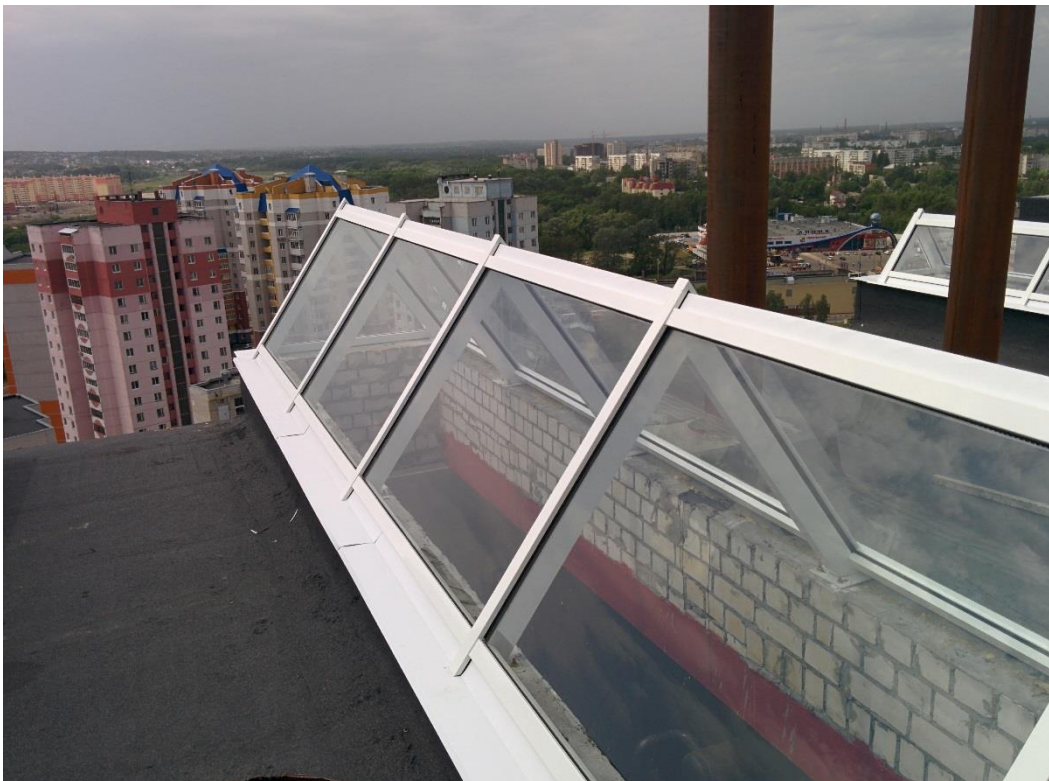
Зенитные фонари на крыше 16-ти этажного жилого дома г. Брянск Московский мкр-н 226
